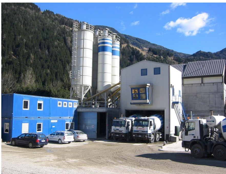
Impianto di calcestruzzo a Gais
