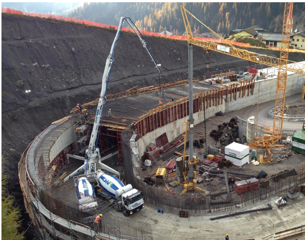
Getto del calcestruzzo
